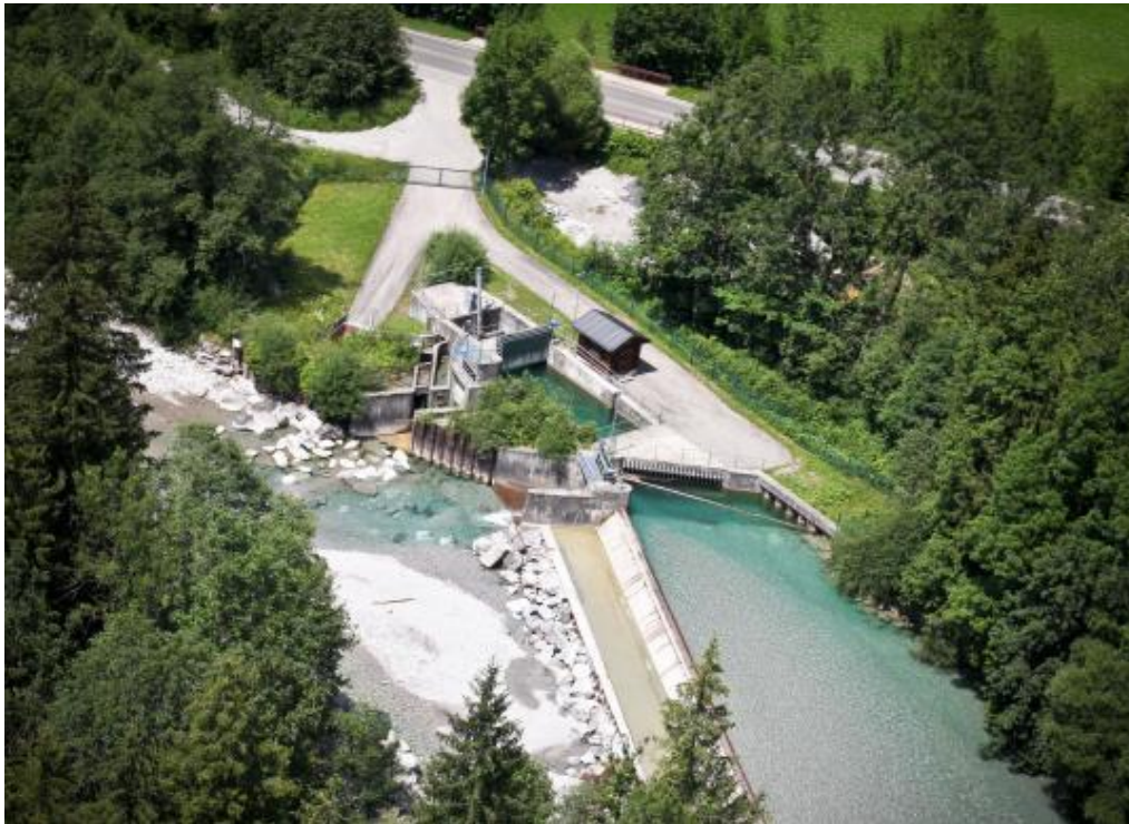
Figure 3.5 - Elektrizitätswerke Hindelang eG
