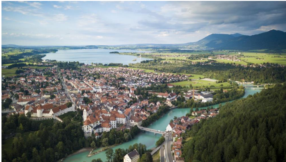
Figure 3.4 - Elektrizitätswerke Reutte pilot site
