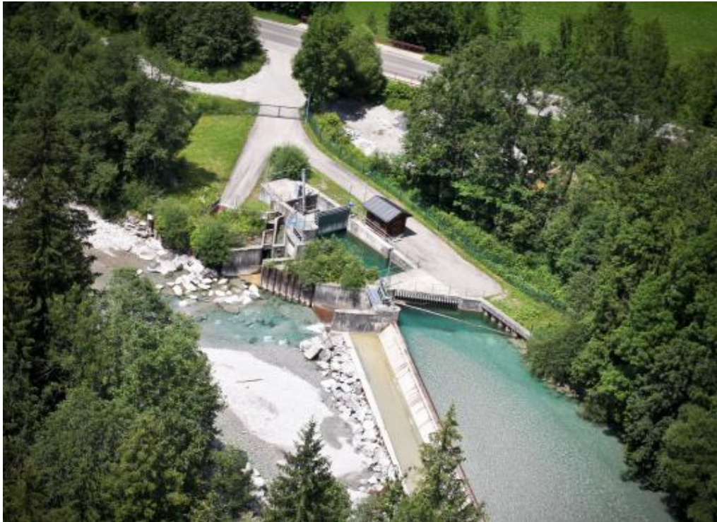
Figure 3-4 - Elektrizitätswerke Hindelang eG
