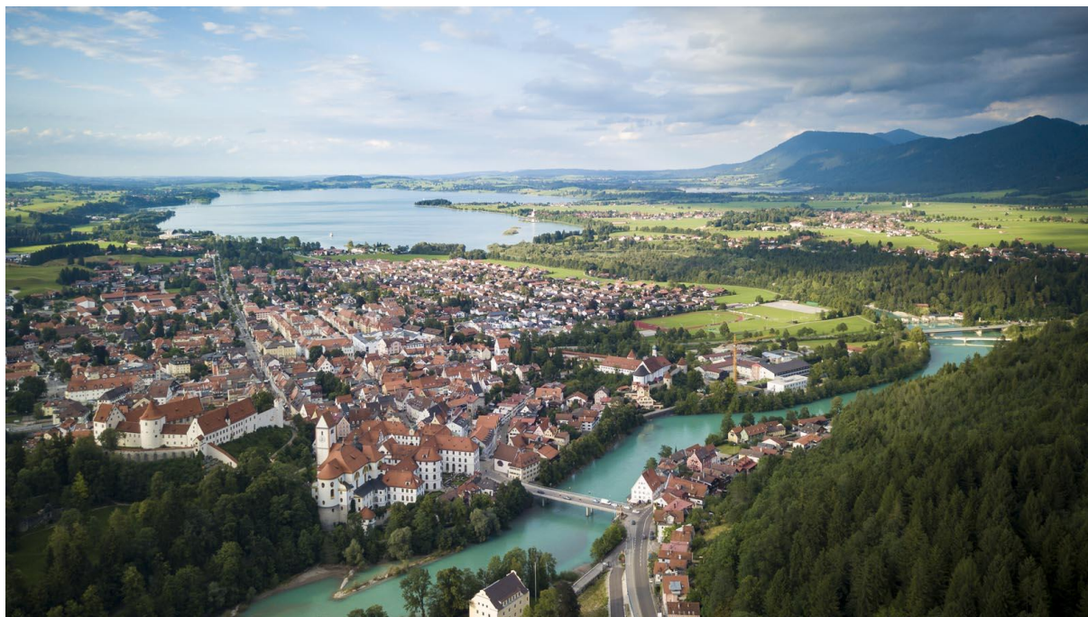
Figure 3.8 – Area of “Elektrizitätswerke Reutte” pilot site
