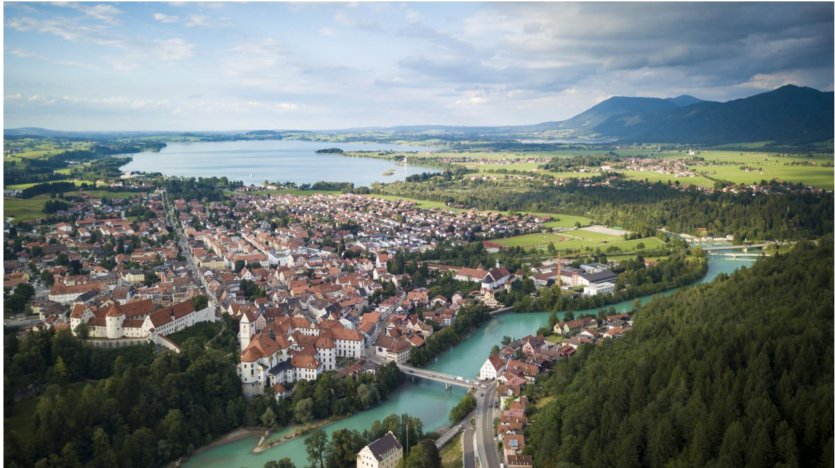
Figure 0.8 – Bereich des Pilotstandorts „Elektrizitätswerke Reutte“
