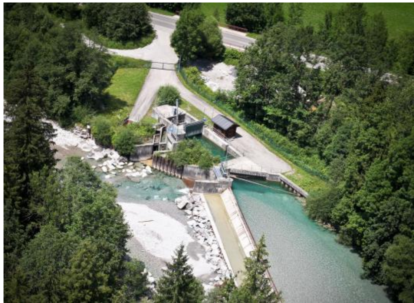
Figure 3.7 – Area of “Elektrizitätswerke Hindelang eG” pilot site
