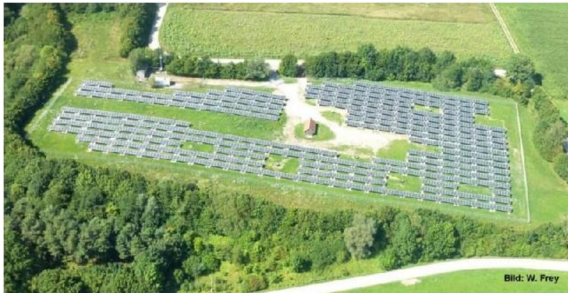
Figure 0.9 – Bereich des Pilotstandorts „Dorfenergie eG“
