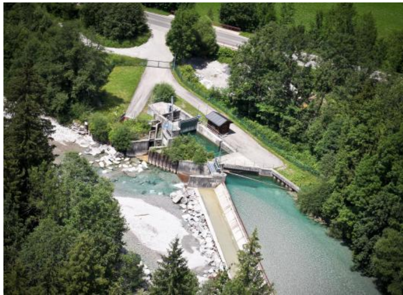
Figure 0.7 – Bereich des Pilotstandorts „Elektrizitätswerke Hindelang eG“
